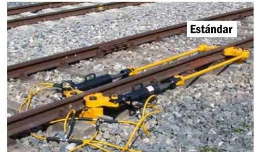
El concepto modular para neutralizar las tensiones del carril antes de la realización de trabajos de soldadura.
